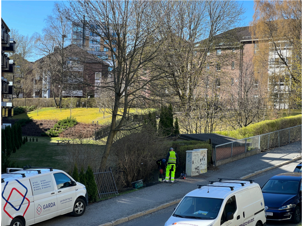
Nytt smijerns gjerde under montering ved Maridalsveien 235 mot Badebakken – 2. mai 2023
