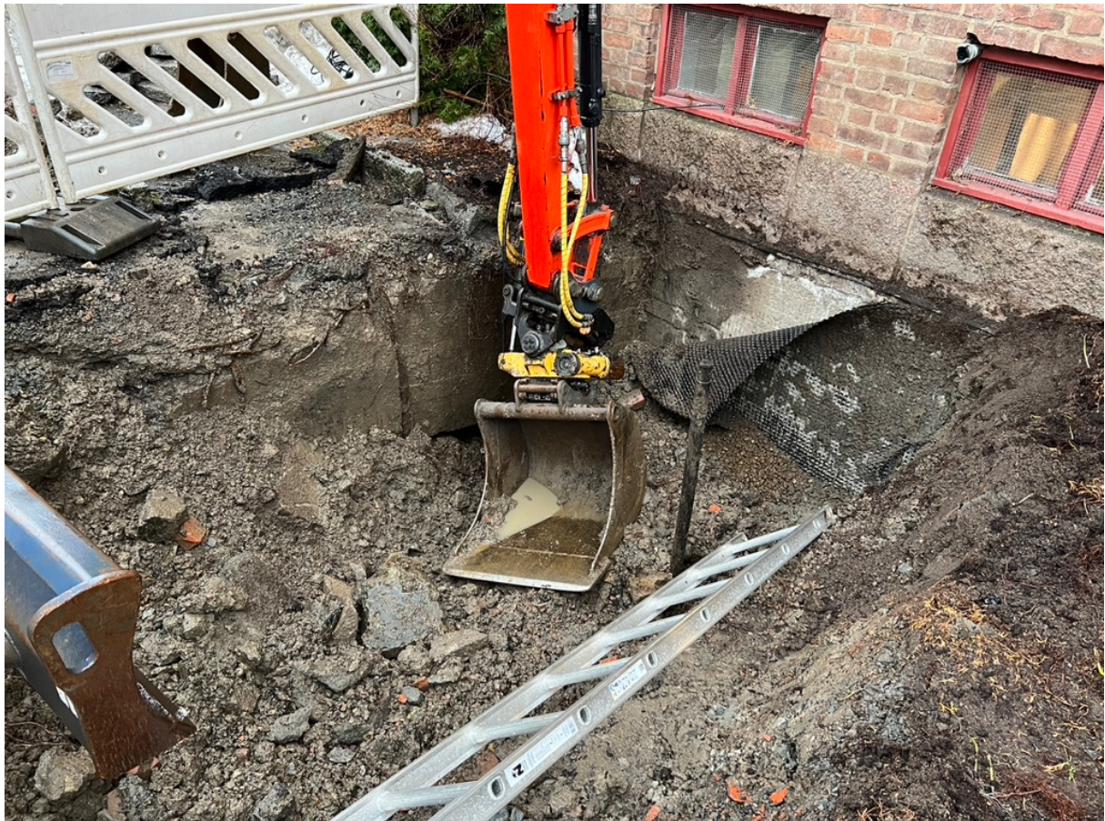
Gravearbeid i forbindelse med utbedring av en vannlekkasje ved Maridalsveien 225D – Mars 2023
