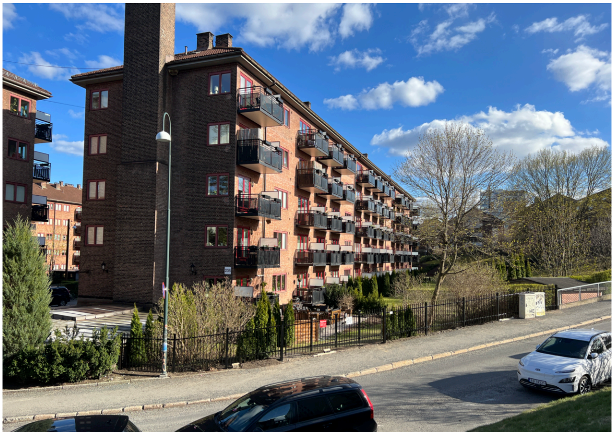
Nytt smijerns gjerde ved Maridalsveien 235 mot Badebakken – 4. mai 2023. Gjerdet har en dobbelt svingport til bruk fra brannbil som adkomst til brannveien bak Maridalsveien 233 og 235.
